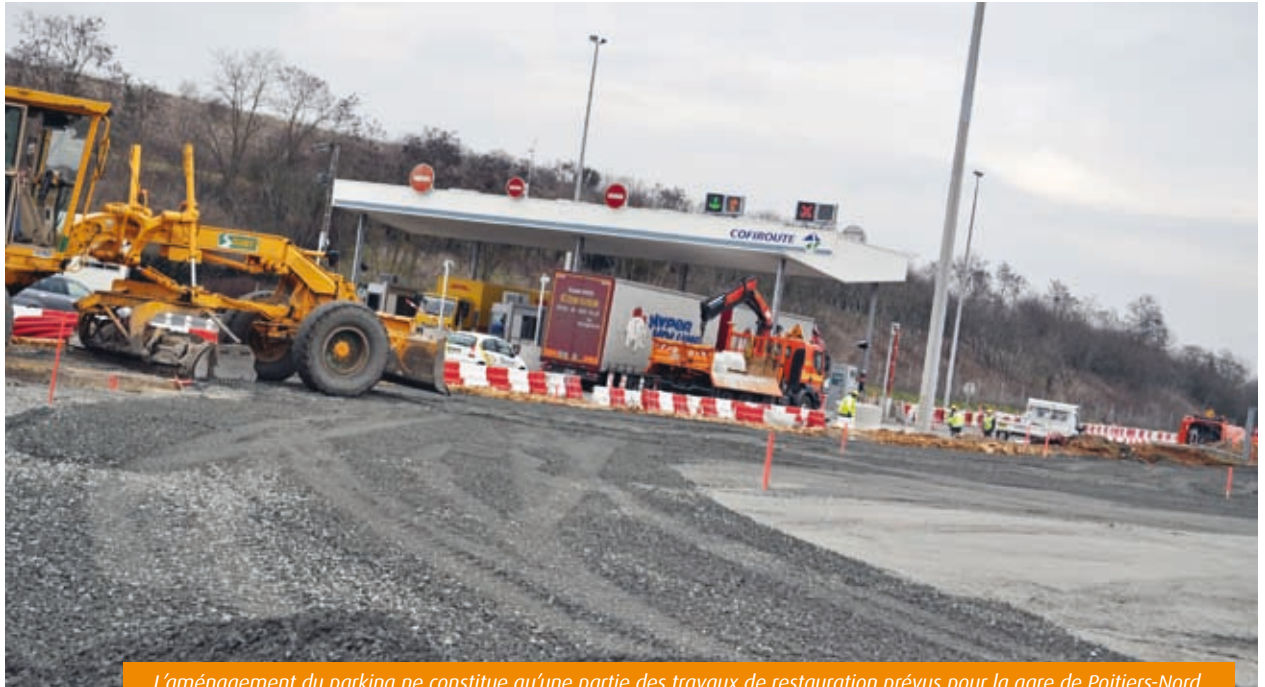
L'aménagement du parking ne constitue qu'une partie des travaux de restauration prévus pour la gare de Poitiers-Nord.
