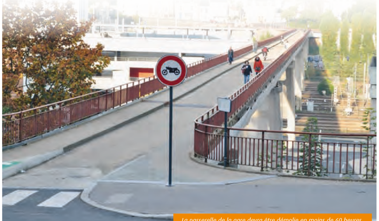
La passerelle de la gare devra être démolie en moins de 60 heures.
